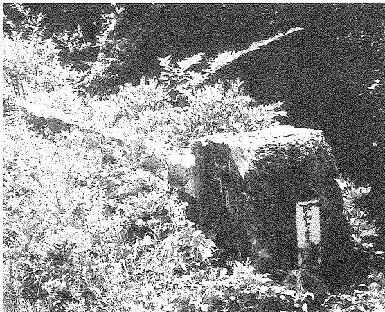
昭和7年完成のコンクリート橋も欄干が崩れている
